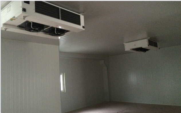
Tavan tipi evaporatör montajı
